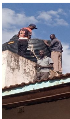
Vattentank till toaletterna sätts upp på taket.
